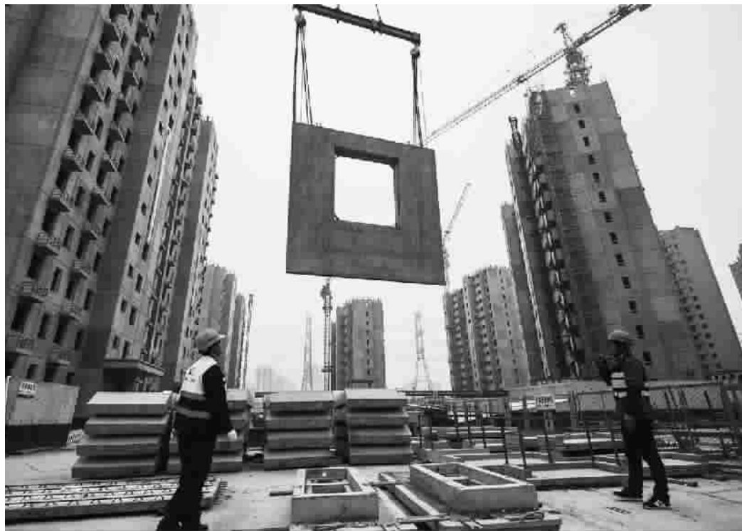
■ 由于施工现场湿作业量大大减少,工地非常干净
