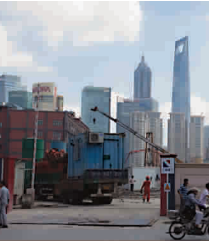
外滩 SOHO 建设工地
