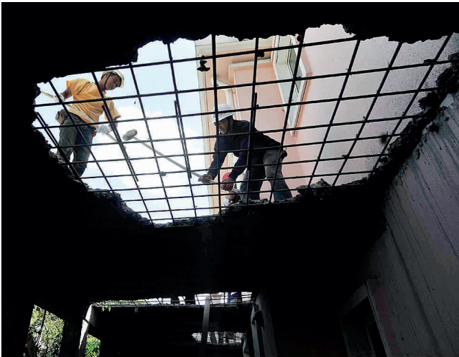
■ 工作人员正在拆除违法建筑
