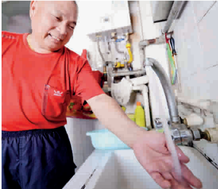
■ 维修后,居民家中的自来水恢复正常流动
