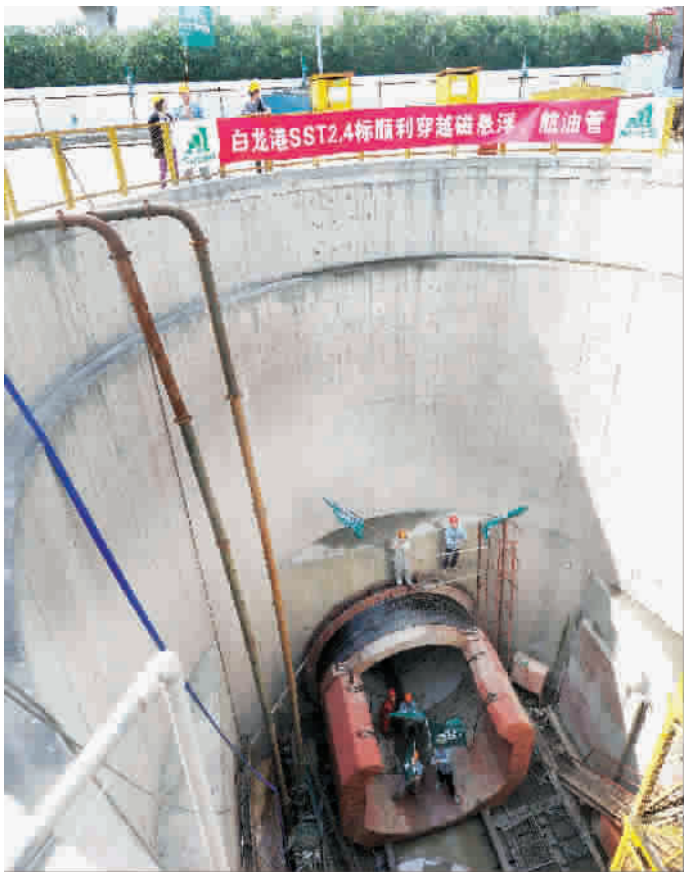
■ 外径4.64米的泥水平衡顶管掘进机顺利穿越磁浮承台基础 本报记者 陈意俊 摄
