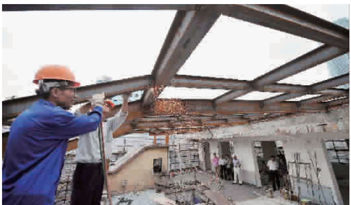
■ 今天上午9点30分，在武进路514号，执法人员正在拆除违法建筑
