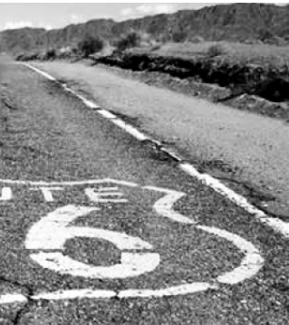
▼ 坑洼开裂的路面
