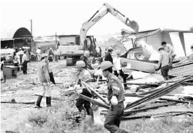
■ 青浦区在广泽公司拆除违法建筑 陶磊 摄
