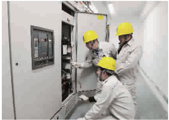
■ 检修外滩路灯配电站
