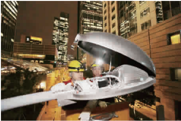
■ 安装调试静安寺路灯
