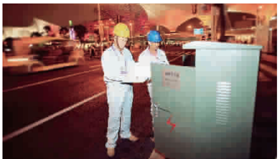
■ 维修世博园区路灯控制箱
