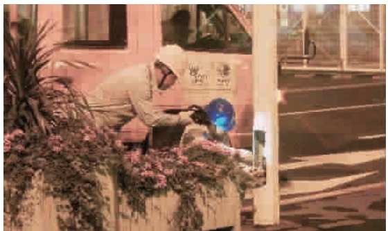
■ 检修浦东南路路灯
