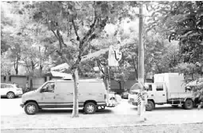
■ 在陆家嘴地区抢修人员正在进行线路带电检修
