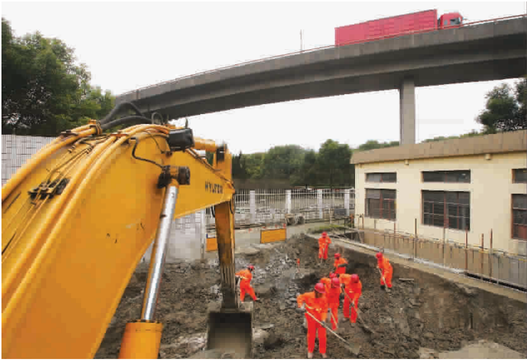
沪闵路下立交改造项目正加紧施工
