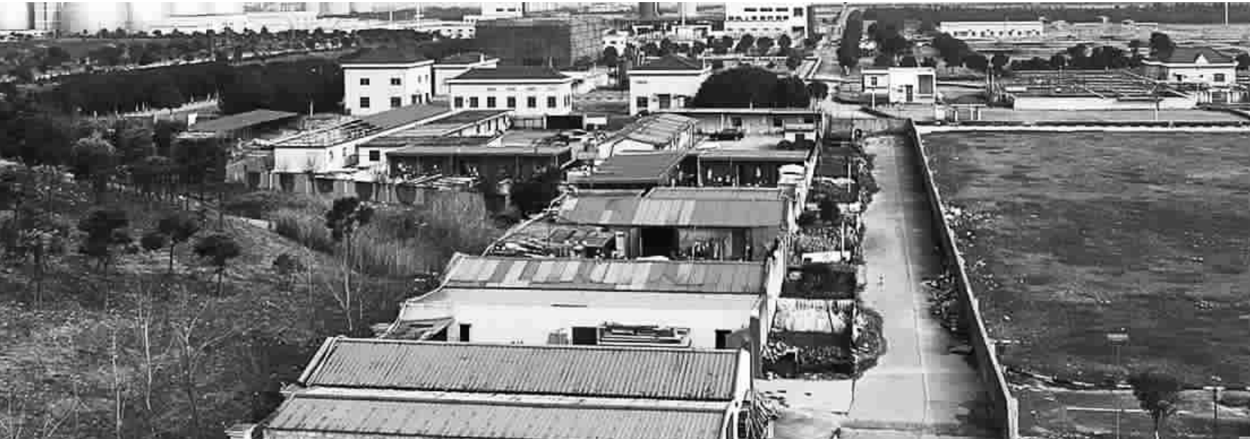
合庆镇仍有许多需要拆除的违法建筑
