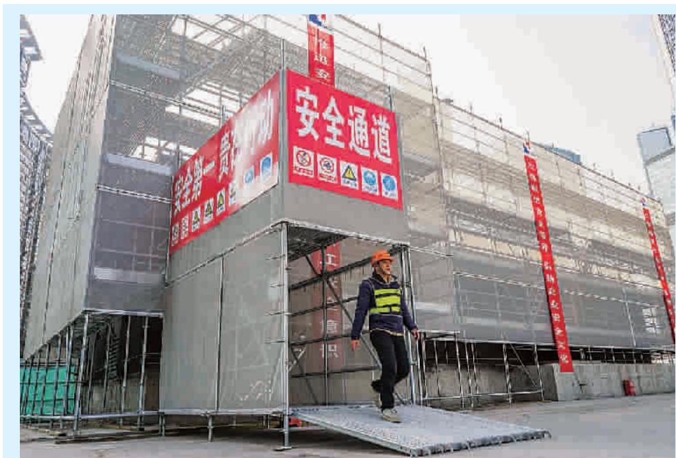
■ 位于中山南路复兴东路路口的建工二建工地采用新型脚手架,能有效防止尘土飘散 本报记者 陈梦泽 摄
