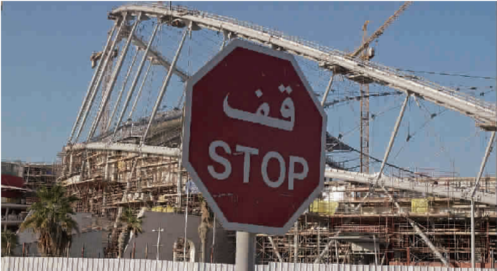
哈里发体育场正在建造中
