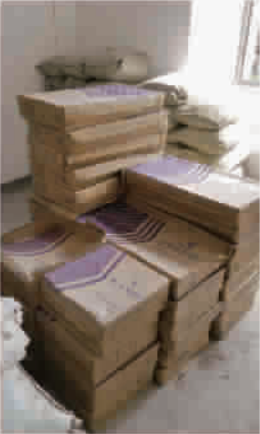
图为开工第二天，材料已现场摆放到位，为后道工序环环相扣保驾护航。
