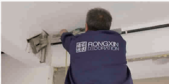
图为开工第二天荣欣师傅正在进行墙面打洞荣欣每位工人经过长期“预制施工”磨练，深谙19天工期要诀。虽然只是施工第二天，他们已经进入了第三天的工序，技术娴熟让每个工地既快又好！
