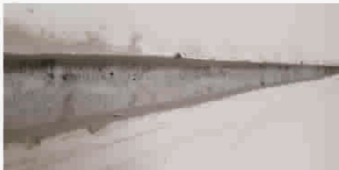
图为墙面开槽
