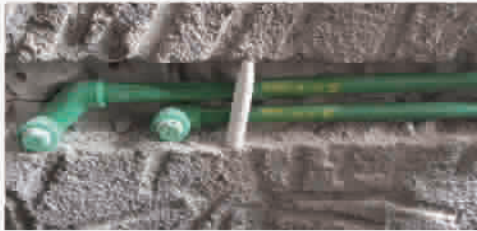
图为安装管道
