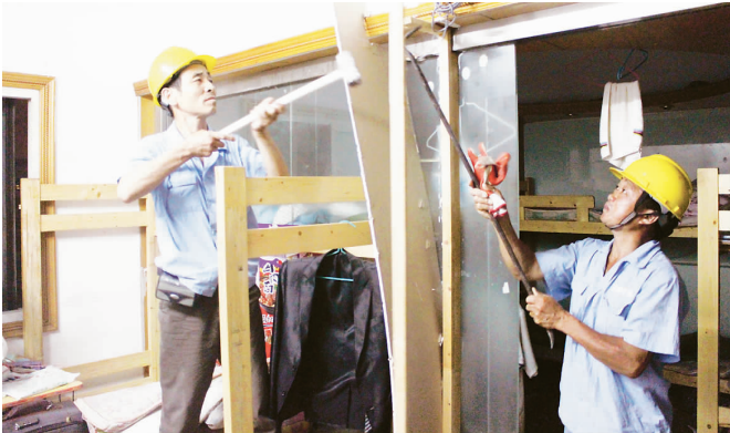
■工作人员将私自违法搭建的隔断及上下铺予以拆除
