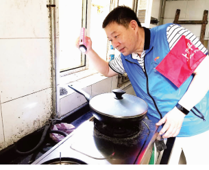
■徐建国为老人检查家中燃气管道
