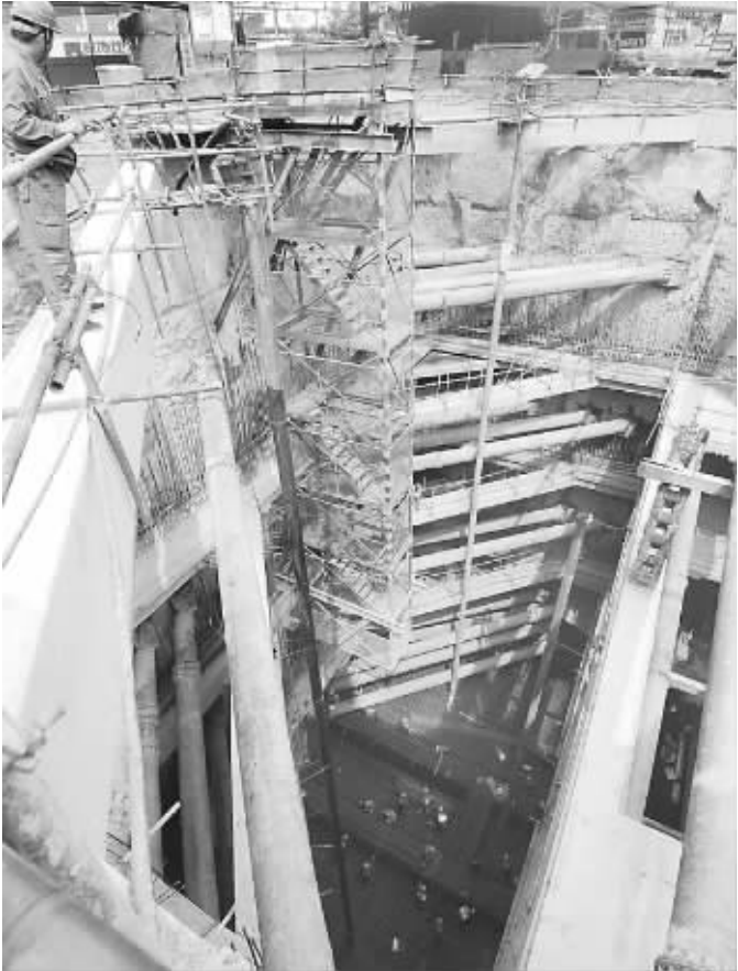
■ 施工中的宜山路地铁站
