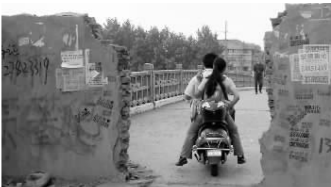
■ 主桥上封堵的围墙屡屡被扒开
