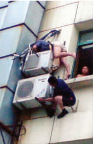
有人爬到窗外拆卸空调外机
