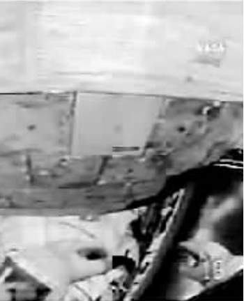
■ 修复前宇航员拍摄的实景
