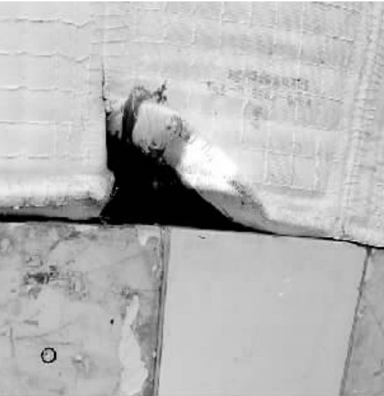
■ 热防护层的裂痕
