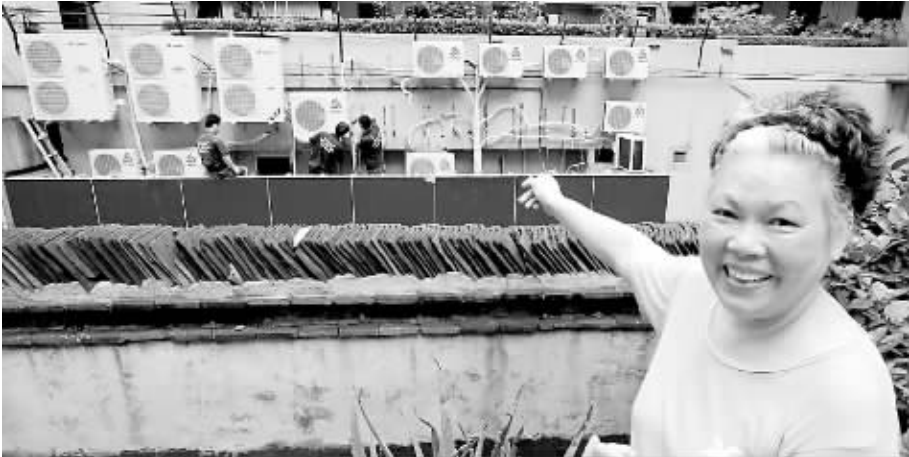
『空调墙』今天拆了!
