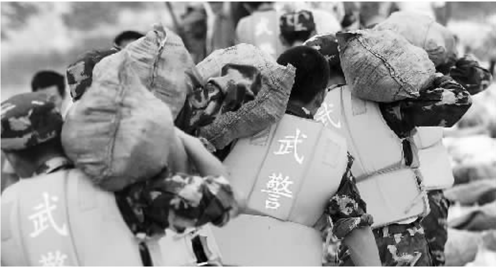
7月14日,武警战士在搬运加固大堤的泥袋。当日,安徽省淮南市凤台县花家湖朱大圩大堤因水位升高和连日浸泡,出现险情,淮南市武警支队迅速出动50余名官兵上堤抢险。
