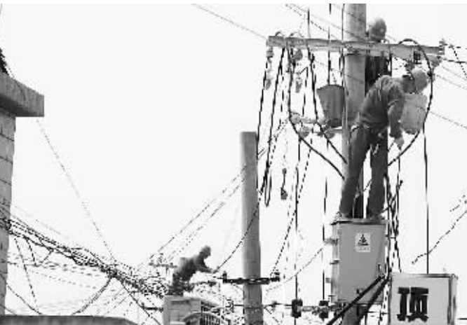
■ 上午，施工人员在烈日下架设电线
