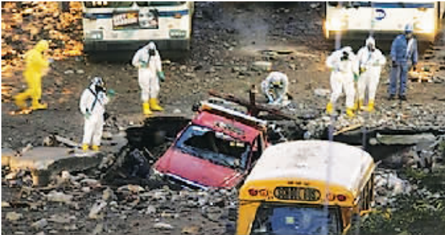
热力管线爆炸引发地面塌陷
