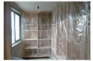
1. 壁柜制作完成后塑料薄膜保护
