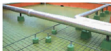
采用双层防水涂料加网格布铺设广场砖等7道工序工艺彻底修缮后的徐汇苑一、二期小区屋顶
