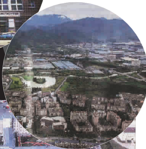
■ 都江堰“壹街区”安居房灾后重建项目
