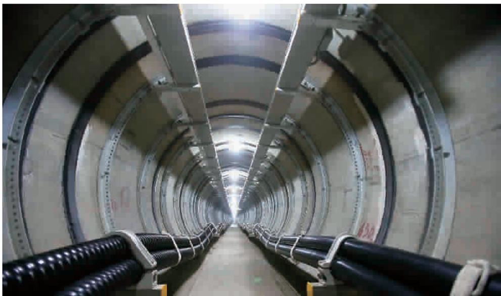
多年来,本市中心城区东北片的电网运行极不稳定,供电缺口日益增大,其中杨行分区168平方公里核心供电区域已面临“无电可供”的紧张局面,不仅造成夏季和冬季用电高峰时期的居民用电困难,还严重制约了地方经济的持续发展,极大影响了上海“四个中心”的建设。虹杨500千伏输变电工程建设将使这一问题迎刃而解,该项进线工程是在杨行变电站至虹杨变电站之间敷设500千伏电缆,形成坚强灵活的500千伏电网网架,简化中心城区的电网结构,缓解中心城区供电压力,提高上海核心区电网的供电可靠性,符合中心城区终端变电站多电源可靠供电的要求。工程建成后可解决本市东北部电网网架薄弱状况,适应地区负荷增长的需求,保证特大型城市的生产和生活用电。
