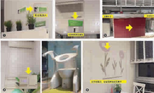
① 明装散热片：升温时间缩短，辐射散热提高，提升舒适；节能又省钱。
