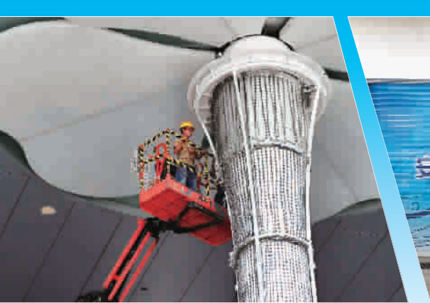
■ 施工人员正在南广场加紧 24 根通体发光节气柱和“四叶草”的发光系统安装 杨建正 摄
