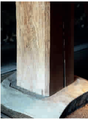
■ 柱础及柱子, 石头与木的精妙结合
