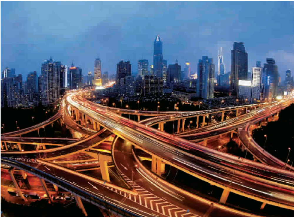
■ 南北高架、延安高架立交
