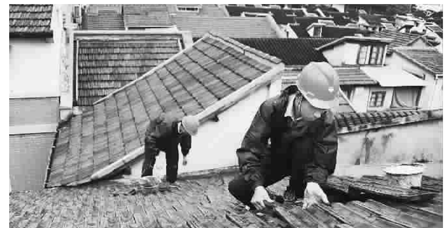
■ 维修人员乘雨停间隙,冒着酷暑在梦花街居民老房的屋顶上“筑漏” 肖健 摄
