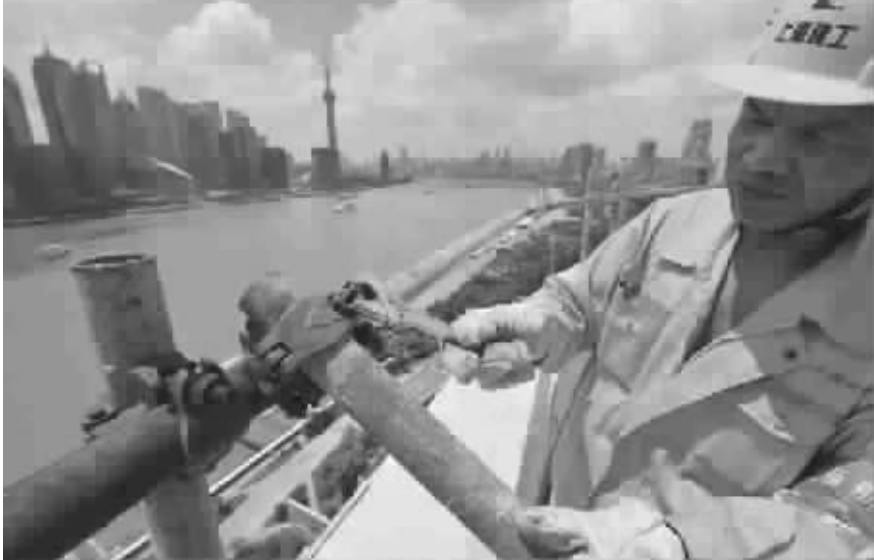
■ 昨天,在北海滩上海港国际客运服务中心工地,工作人员在加固脚手架
