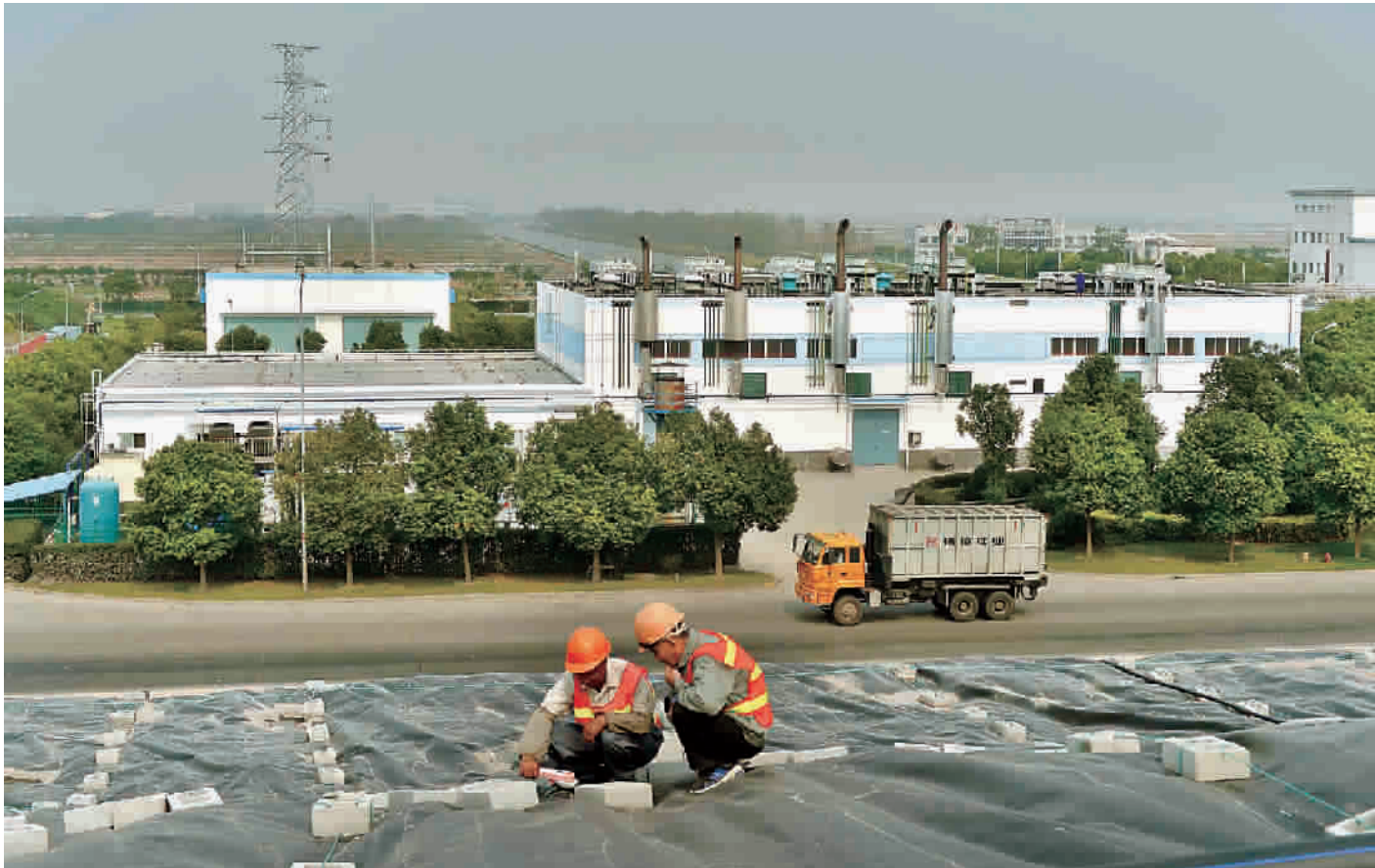
■ 图为从近 30 米高的填埋垃圾堆体上，俯瞰上海老港垃圾填埋气发电项目 本报记者 张欣平 孙中钦 摄影报道
