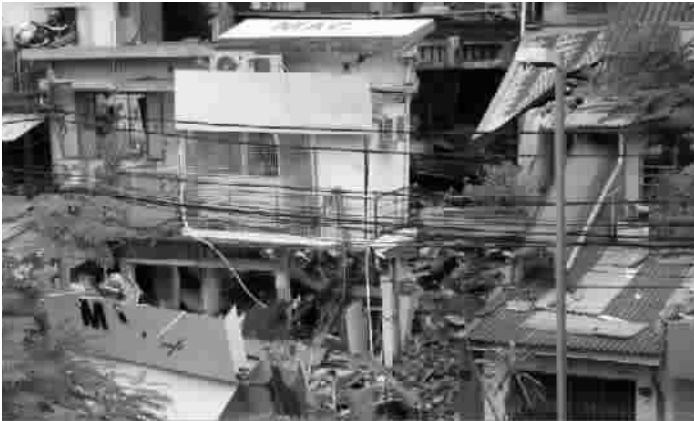
■发生爆炸的居民区
