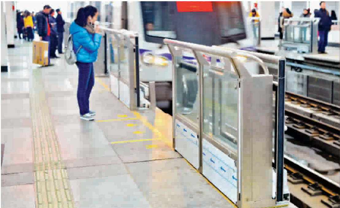
轨交3、4号线金沙江路站安全门基本安装完毕 针对轨交3、4号线金沙江路站的大客流,相关部门于近日在该站安装了安全门,调试完成后将投入使用。此举将明显提高乘客的候车安全系数。 见习记者 陈梦泽 摄影报道
