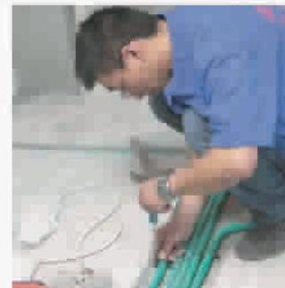
△图为俯身地坪的这位师傅,执行的是波涛自成一格的从难从严施工工艺——所有线管、水管必须用管卡固定,且“管卡距离为80cm,弯头处固定距离为15cm”。
