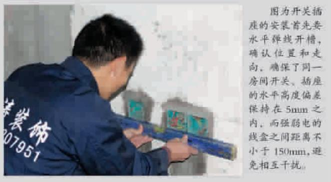
图为开关插座的安装首先要水平弹线开槽,确认位置和走向。确保了同一房间开关、插座的水平高度偏差保持在5mm之内。而强弱电的线盒之间距离不小于150mm,避免相互干扰。
