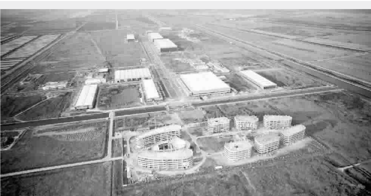
■ 建设中的中国商飞上海飞机制造有限公司总装浦东基地
