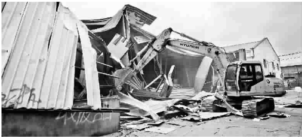
今天上午的拆违现场
