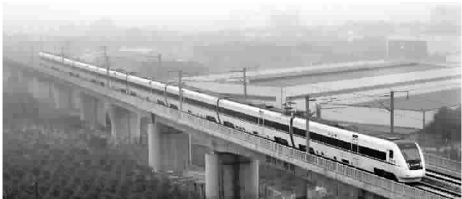
■ 12 月 20 日，一辆动车在成绵乐铁路客运专线眉山市驶过
