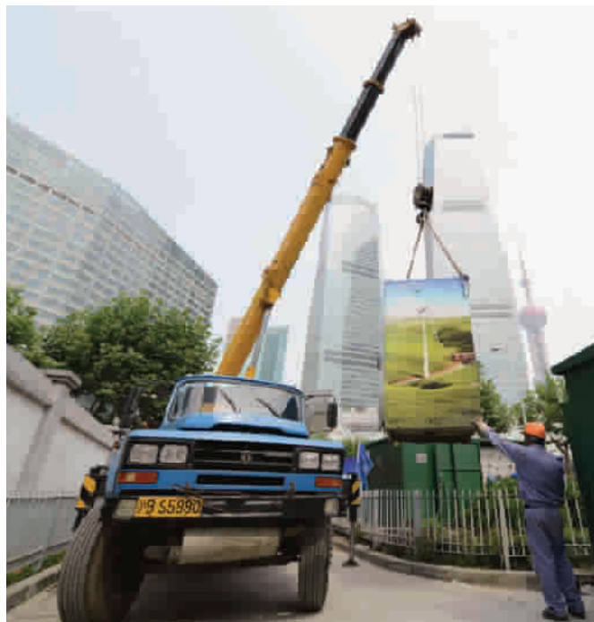
■ 自贸区扩容区域电网改造工程 张锐楠 摄
