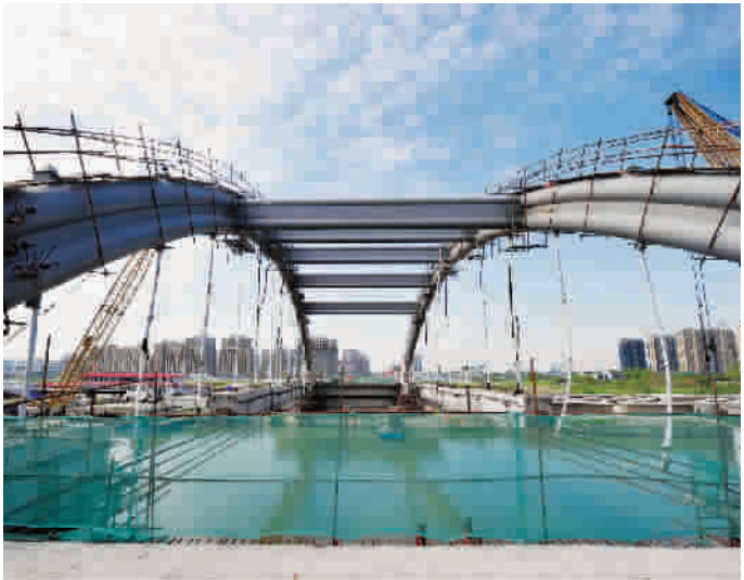
正在兴建的浦南运河桥将缓解附近的交通压力 陶磊 摄
