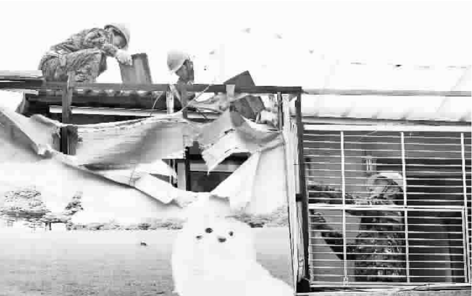
■嘉定区上海原封养犬场拆违
