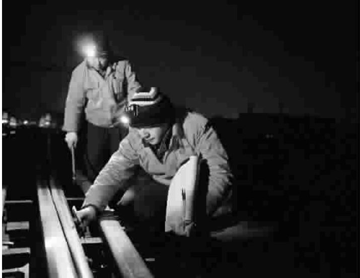
王渊博在测量和记录钢轨的间隙
