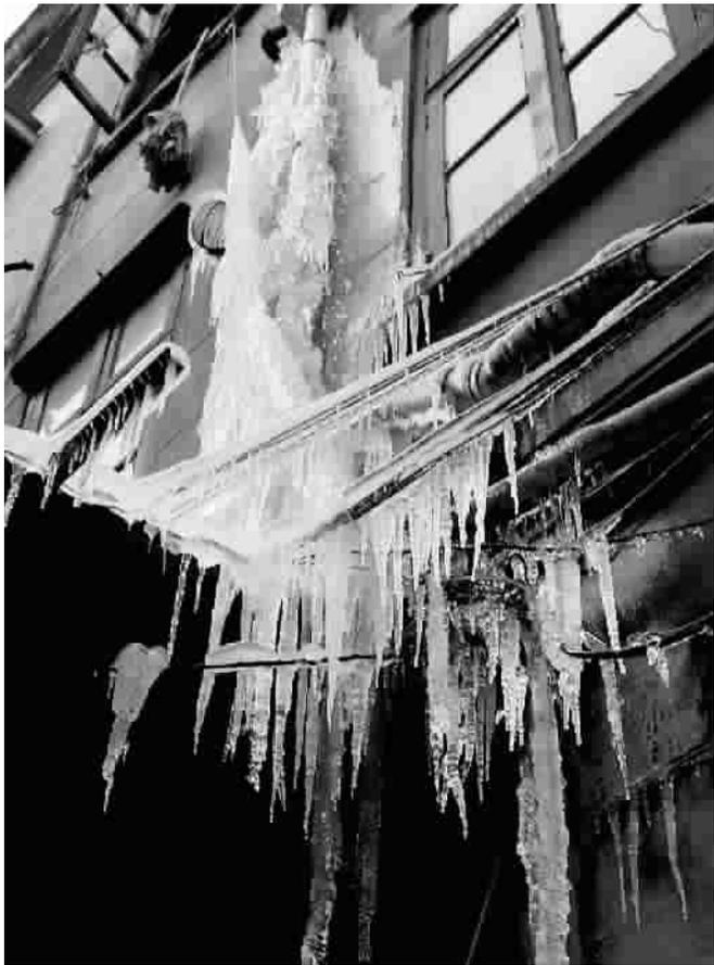
塘沽路近长洽路的一老旧小区里破裂的落水管上挂满冰凌 任国强 摄
