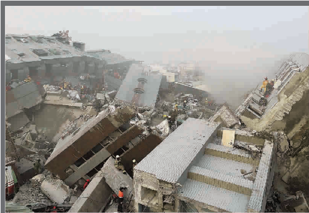
■ 倒塌的大楼令人惨不忍睹
