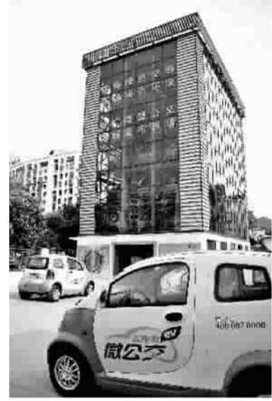
■杭州正在建立微公交网点系统,配有纯电动汽车智能充电换电立体车库
