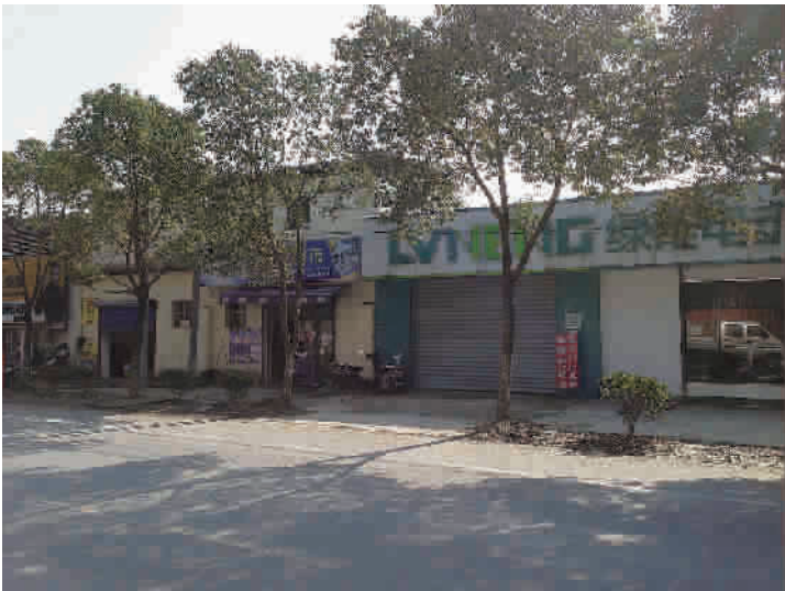
沪杭公路南庄路西侧破墙开店脏乱差
